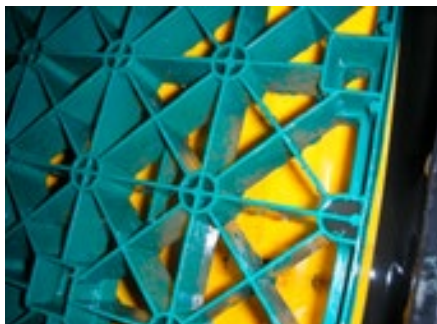
Gereinigde installatie zonder bezinsel, hier bij de stromingscheider
