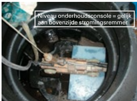
Controle van de reiniging d.m.v. een rioolinspectiecamera. De camera staat op de onderhoudsconsole van een SediPipe L-installatie
