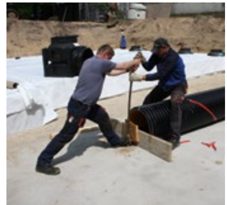
Montage sedimentatiebuis
